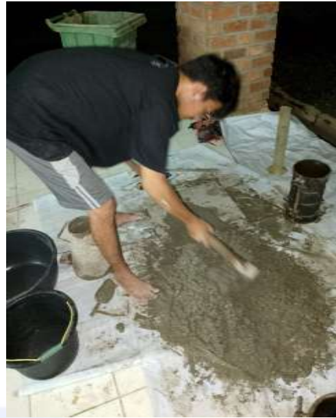
Proses pengadukan campuran beton
