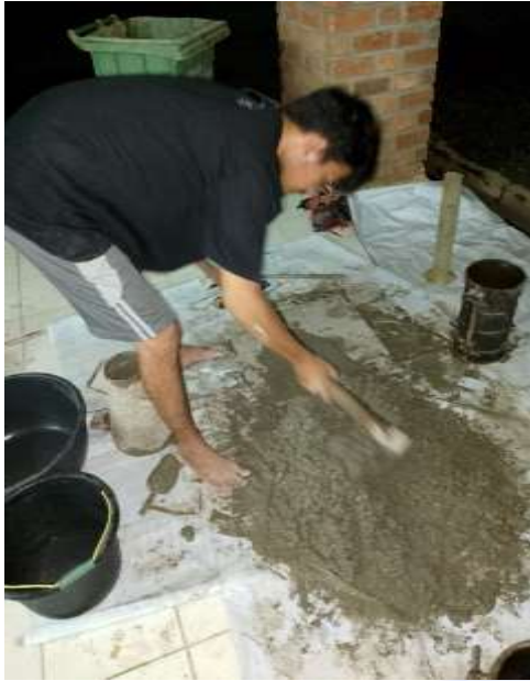
Aduk campuran beton
