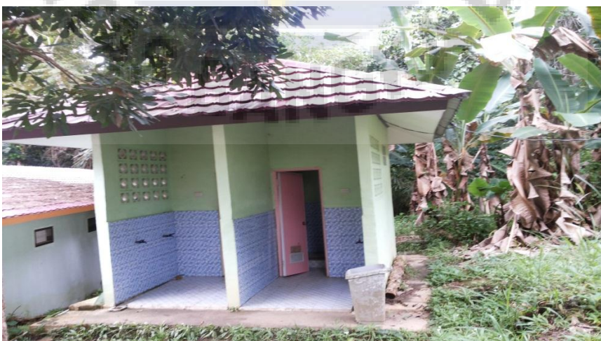
18. Wc Umum di Area Atas
