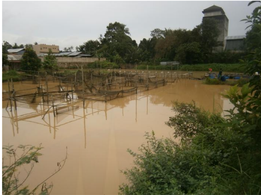
Foto Kondisi Kulong Pedindang 1
