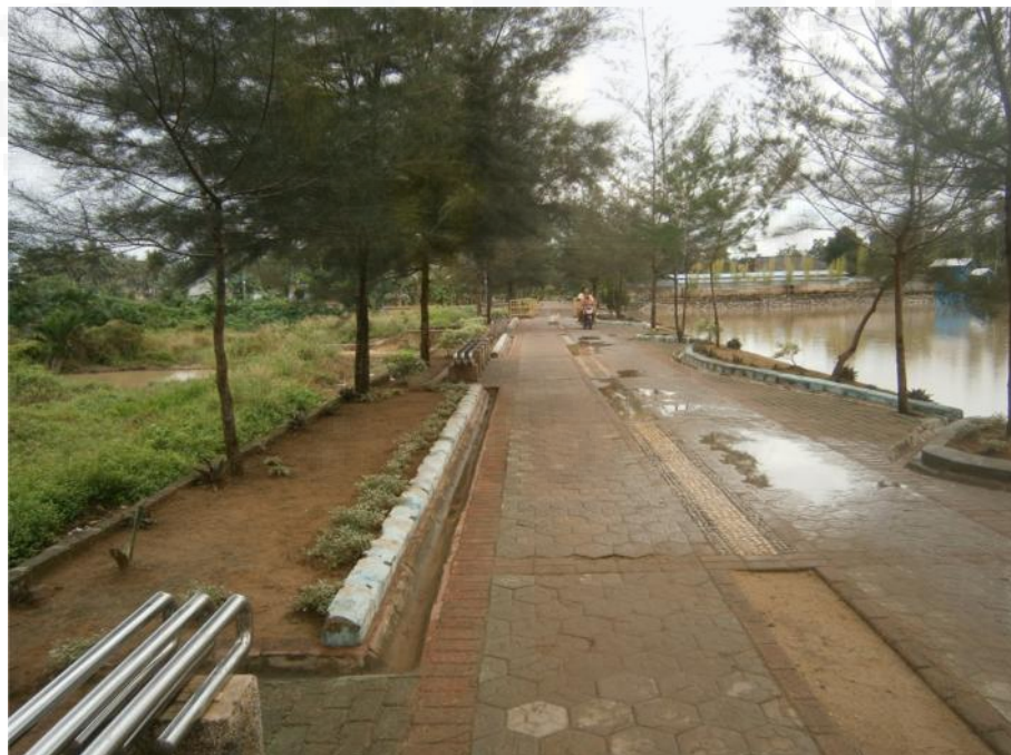
Foto Akses Jalan Kulong Beguruh
