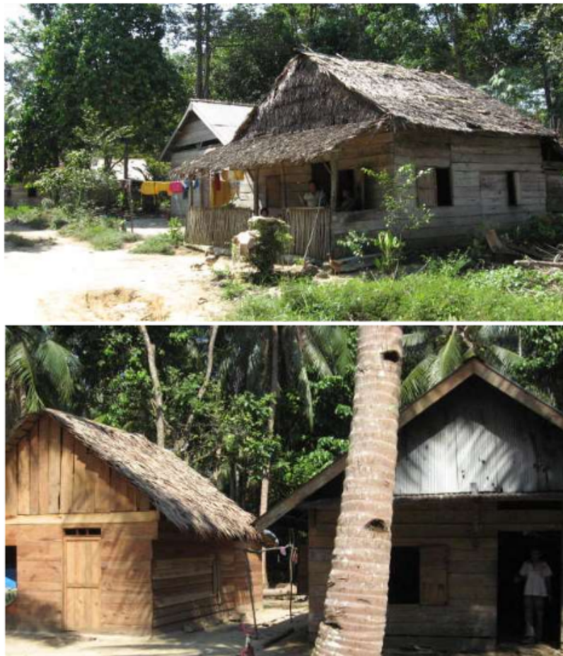
Gambar 12. Kondisi pemukiman penduduk di Desa Penagan yang sebagian besar bekerja di sektor penambangan inkovensional.
