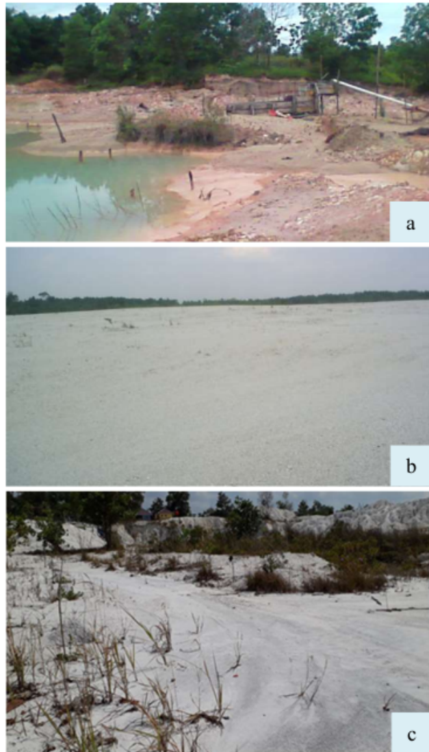
Gambar 6. Bentuk kerusakan akibat penambangan timah (a) kerusakan fisik tanah, (b, c) hamparan tailing pasir pasca penambangan timah.
