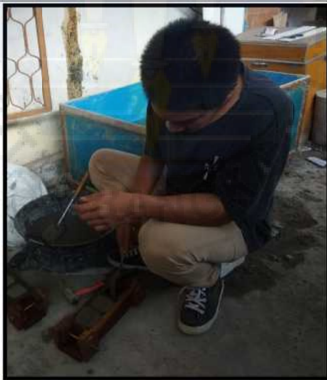
Memasukkan adukan mortar ke dalam cetakan
