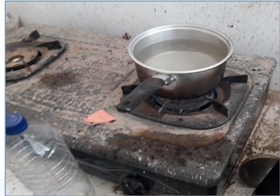
2. Untuk pembuatan beton diatas temperatur normal, air payau dipanaskan terlebih dahulu
