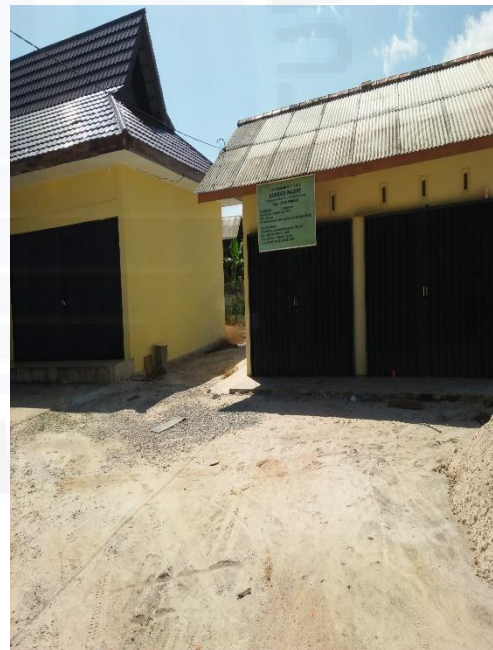
Pembangunan gedung BUMDes
