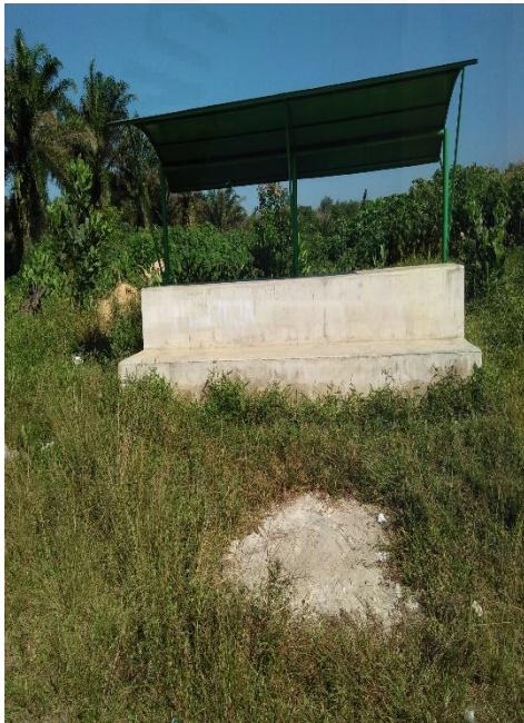
Pembangunan tribun lapangan bola
