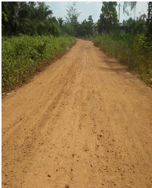
Pembangunan jalan gang
