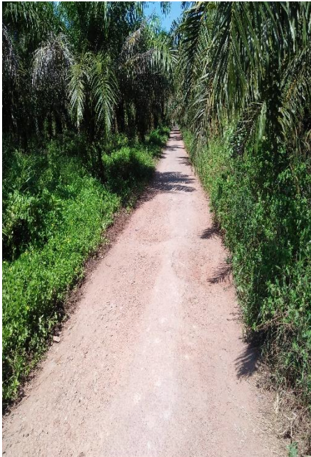
Pembangunan jalan usaha tani
