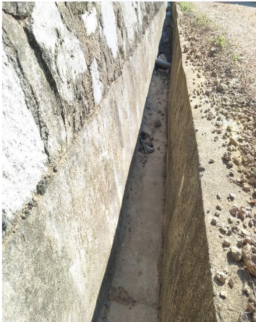
Pembangunan saluran air
