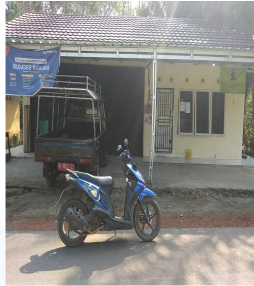
Pembangunan gedung BUMDes
