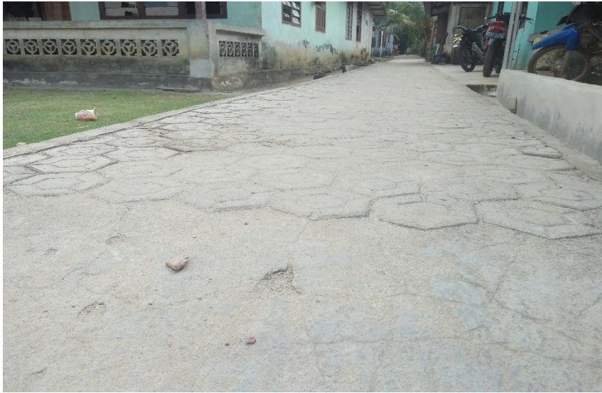
Pembangunan jalan setapak
