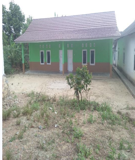
Pembangunan gedung PAUD
