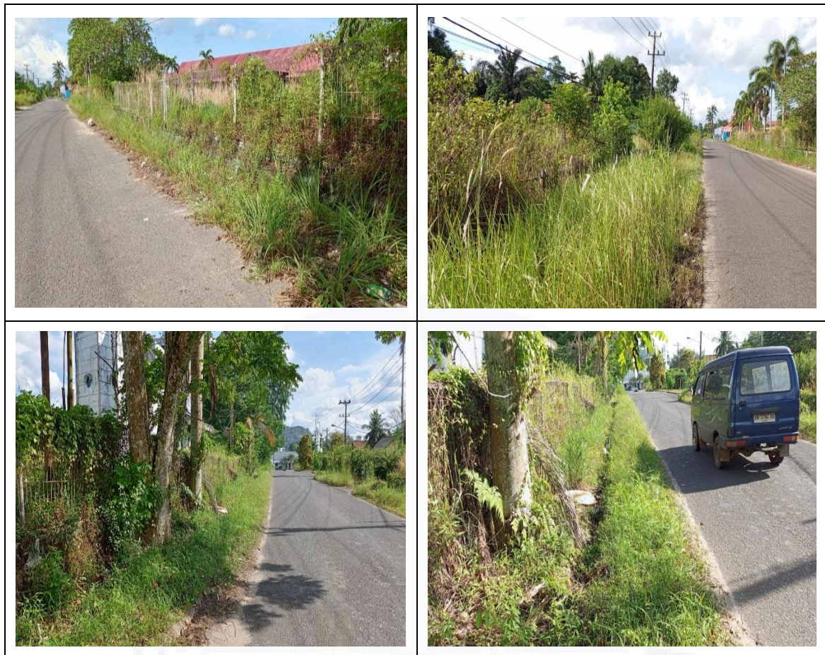
Gambar 4. 18 Dokumentasi Kondisi Eksisting dari Bahu Jalan (Sumber: Penulis, 2025)
