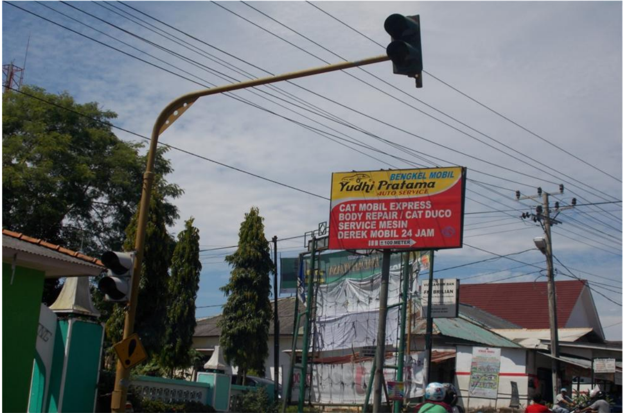
Kondisi Rambu-Rambu Peringatan Yang Mati di Ruas Jalan Gabek Raya
