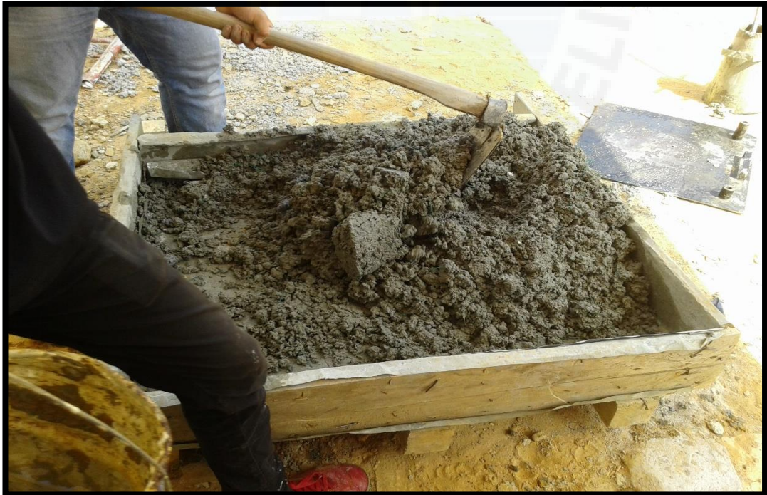
Gambar 5.38 Proses pengadukan campuran beton kertas
