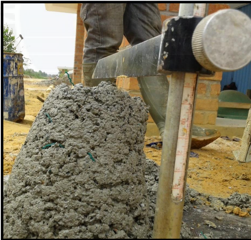
Gambar 5.40 Pembacaan nilai slump beton kertas
