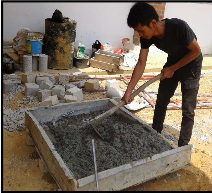
Gambar 5.39 Proses pengadukan campuran beton kertas
