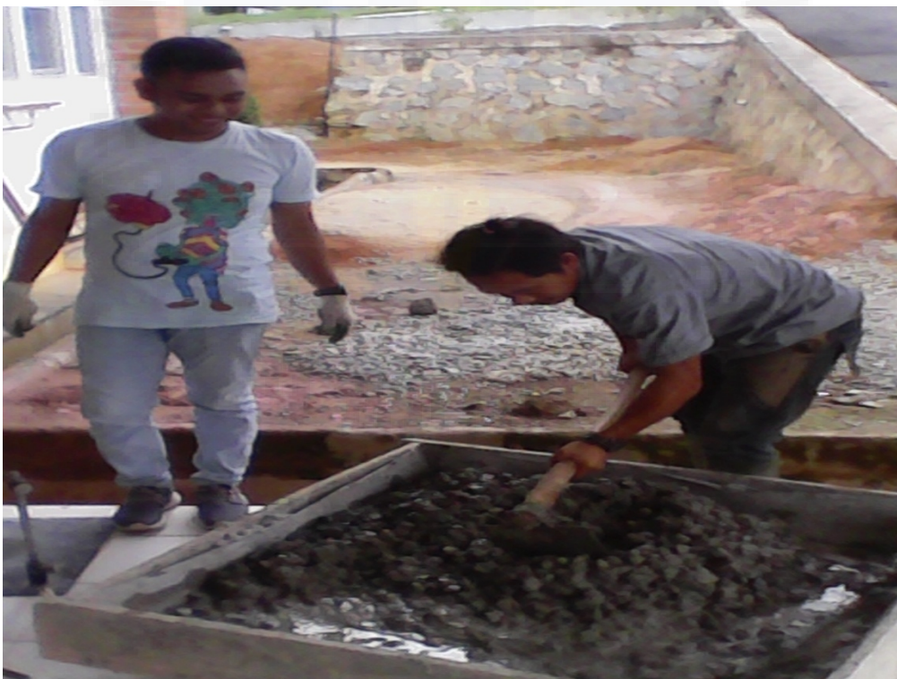
Gambar L.D.18 Hasil Pengadukan Beton
