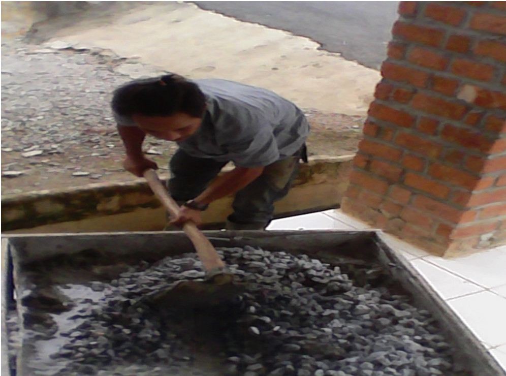
Gambar L.D.17 Proses Pengadukan dan Pencampuran Beton
