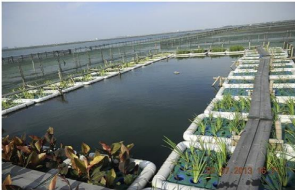
Gambar 23. Ilustrasi dari suatu konsep Eco-dam dengan zona bioremediasi mengelilingi zona breeding ; submerged biofilter (SBF) dan plant floating bed (PFB).
