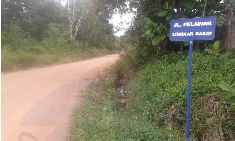
Gambar 1. Foto Jalan Tanah yang Telah Diperbaiki
