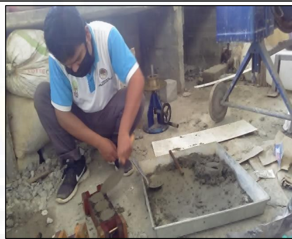
(b) Proses Perataan Adukan Mortar Kedalam Cetakan
