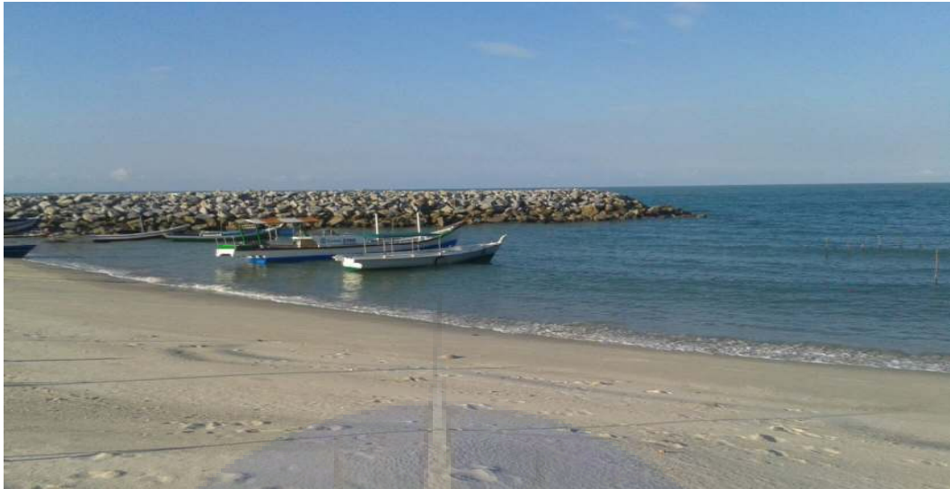
Talud pemecah ombak dan tempat berlabuh perahu nelayan
