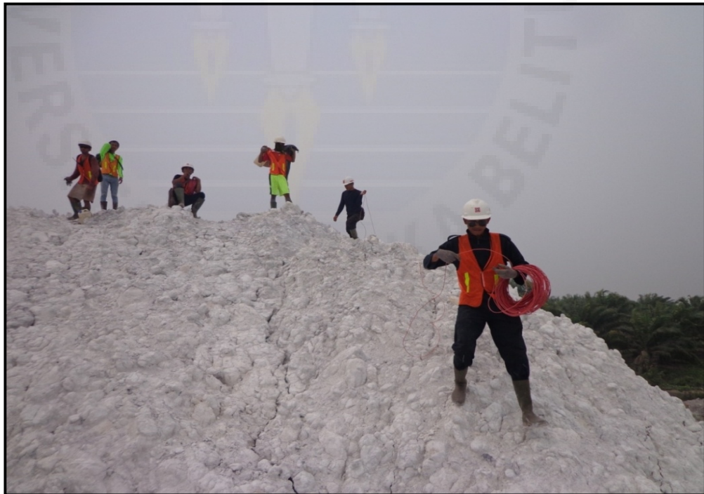
Gambar C.2. Kondisi Lintasan C Berada Diatas Tanah Galian Tambang
