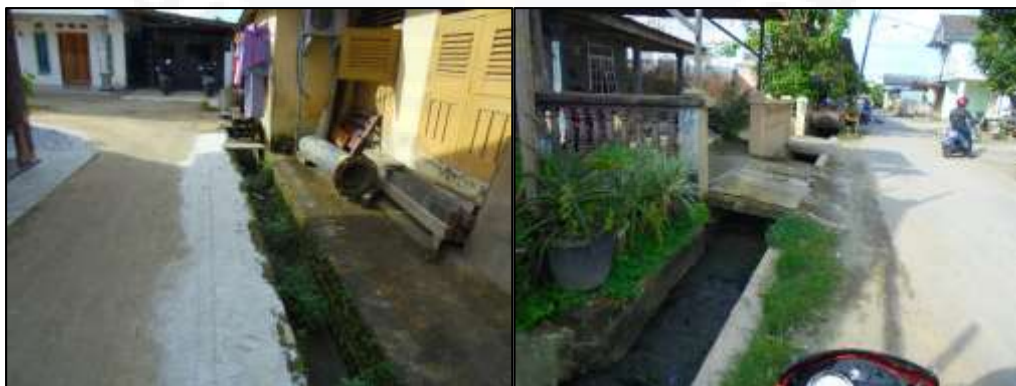
Gambar 1.1 Kondisi drainase yang dipenuhi air limbah domestik
