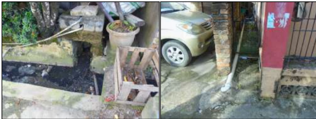
Gambar 1.3 Tidak adanya pengolahan air limbah, dan air limbah langsung dibuang di drainase
