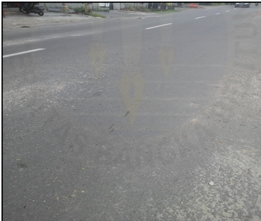
Gambar Kerusakan Keriting STA 0+335
