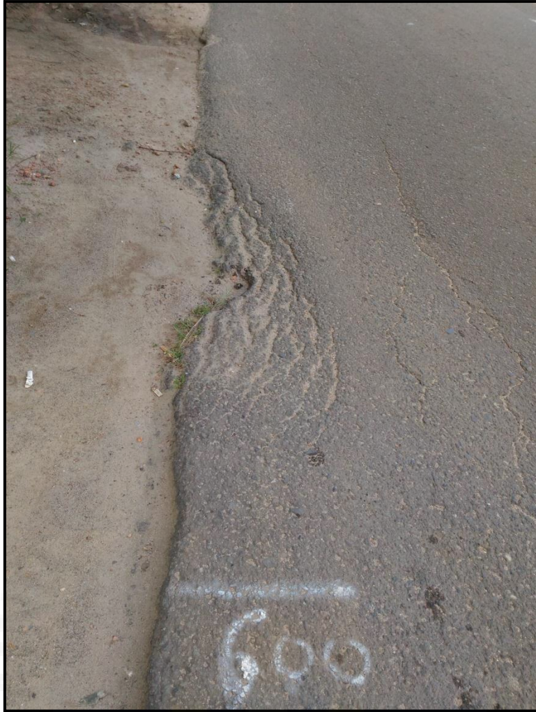
Gambar Kerusakan Retak Selip STA 0+601
