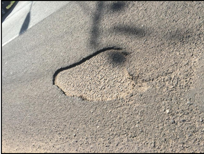
Gambar Kerusakan Lubang
