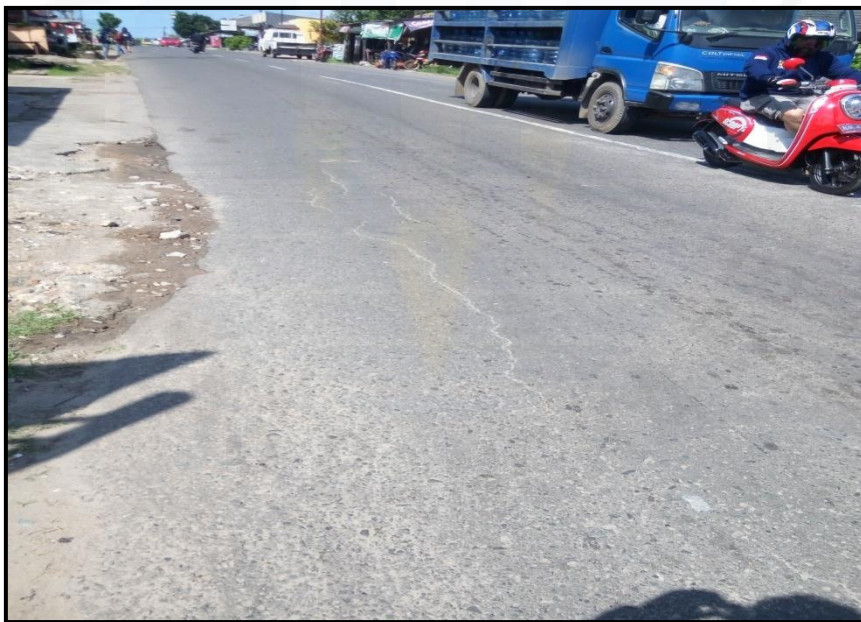
Gambar Kerusakan Retak Memanjang STA 0+094
