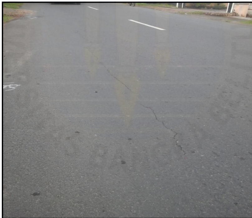
Gambar Kerusakan Retak Memanjang STA 0+375
