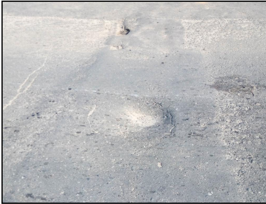
Gambar Kerusakan Lubang STA 0+226
