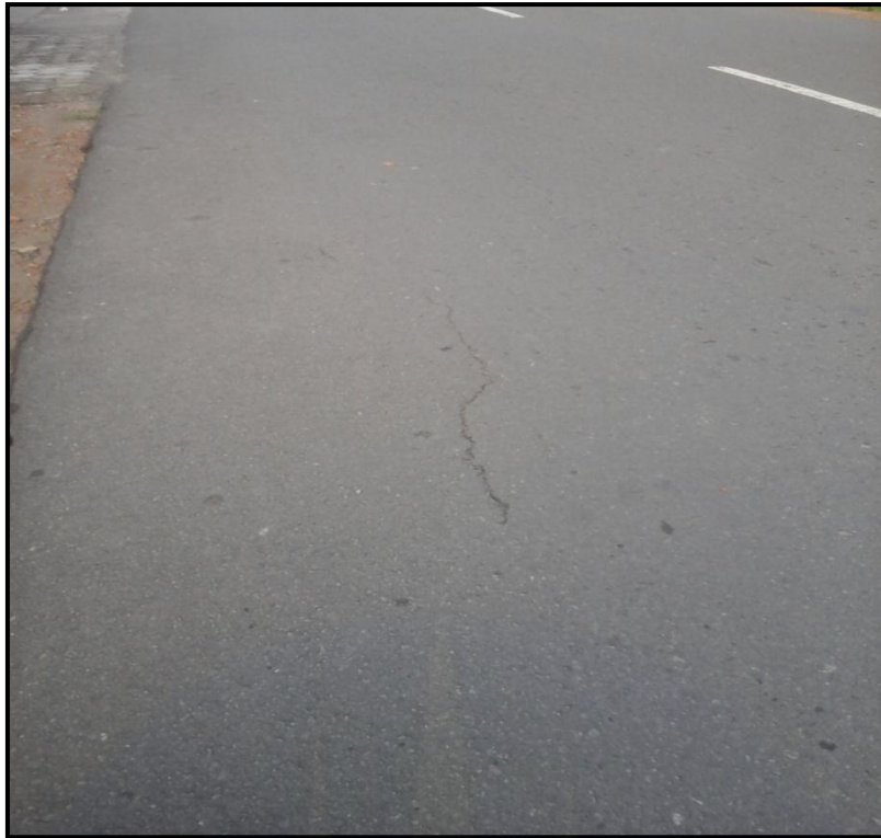
Gambar Kerusakan Retak Memanjang STA 0+430
