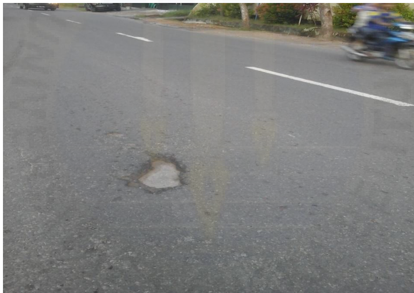
Gambar Kerusakan Lubang STA 0+985
