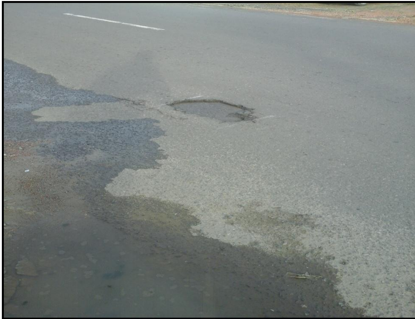
Gambar Kerusakan Lubang STA 0+132
