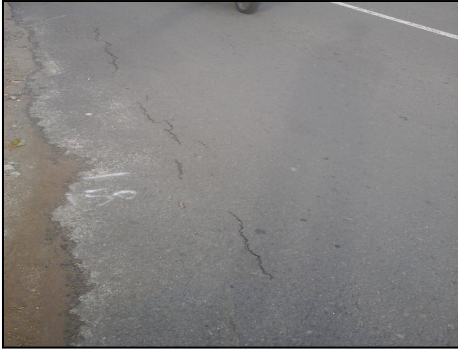
Gambar Kerusakan Retak Memanjang STA 0+157
