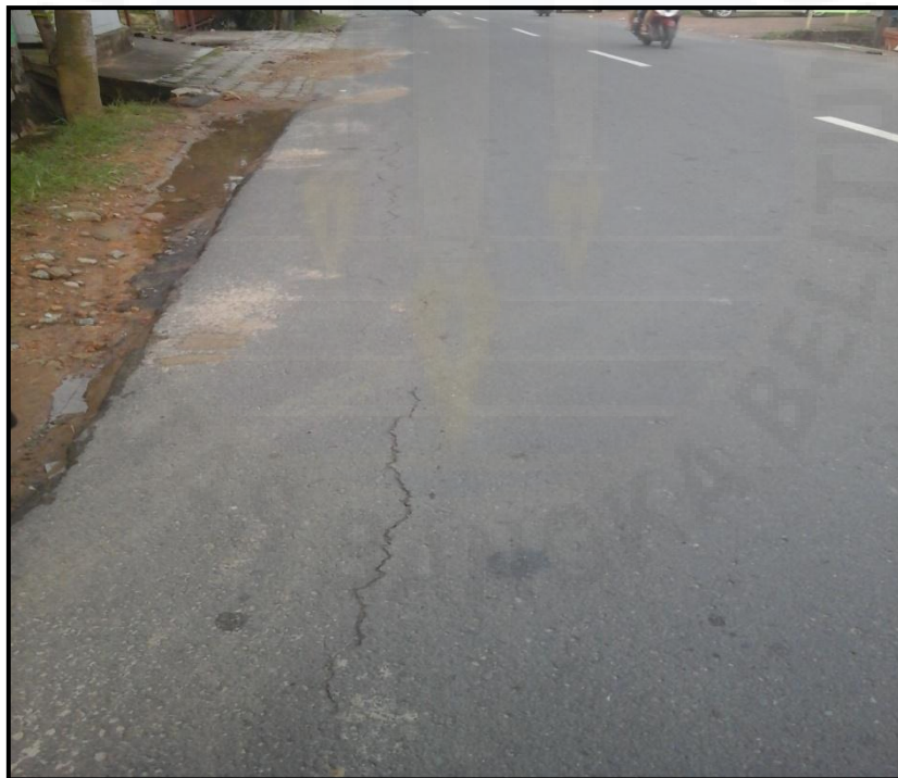
Gambar Kerusakan Retak Memanjang STA 0+277
