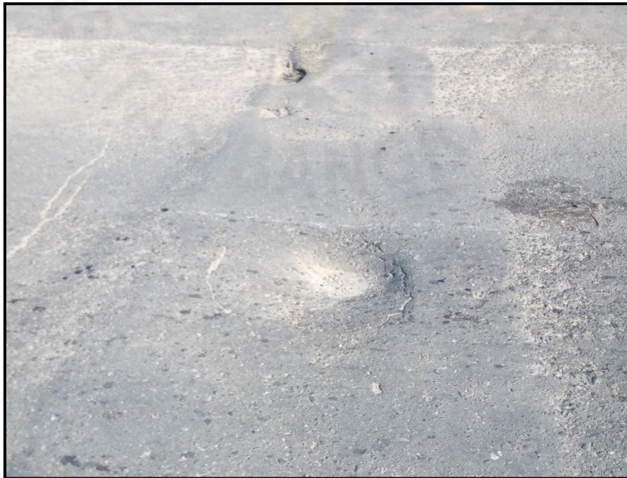
Gambar Kerusakan Retak Selip STA 0+601
