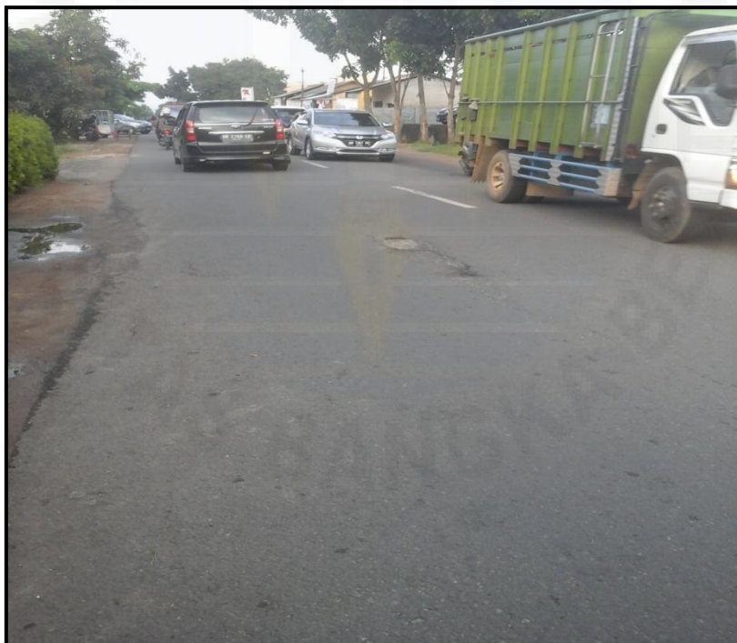
Gambar Kerusakan Keriting STA 0+535
