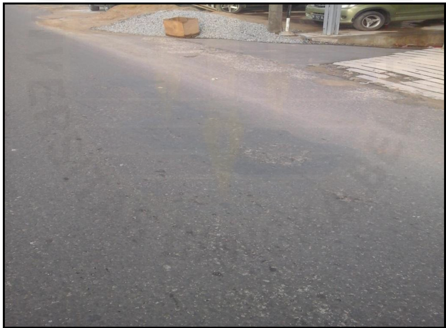
Gambar Kerusakan Tambalan STA 0+160
