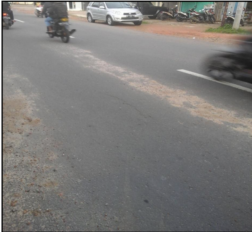
Gambar Kerusakan Retak Memanjang STA 0+310
