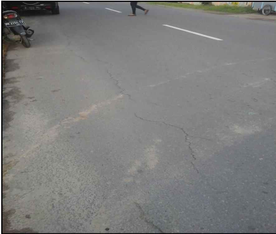
Gambar Kerusakan Retak Memanjang STA 0+362
