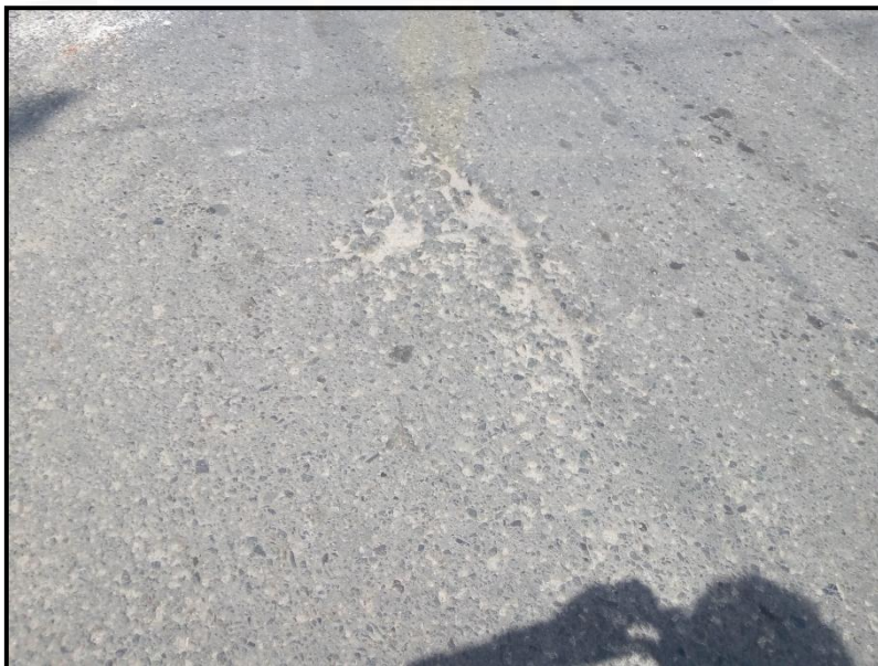
Gambar Kerusakan Keriting STA 0+975
