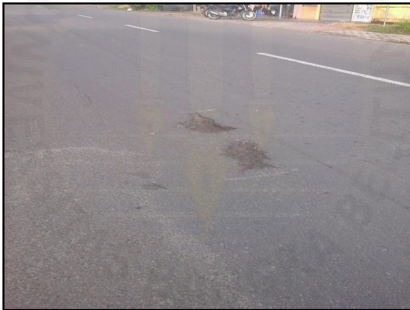
Gambar Kerusakan Keriting STA 0+062
