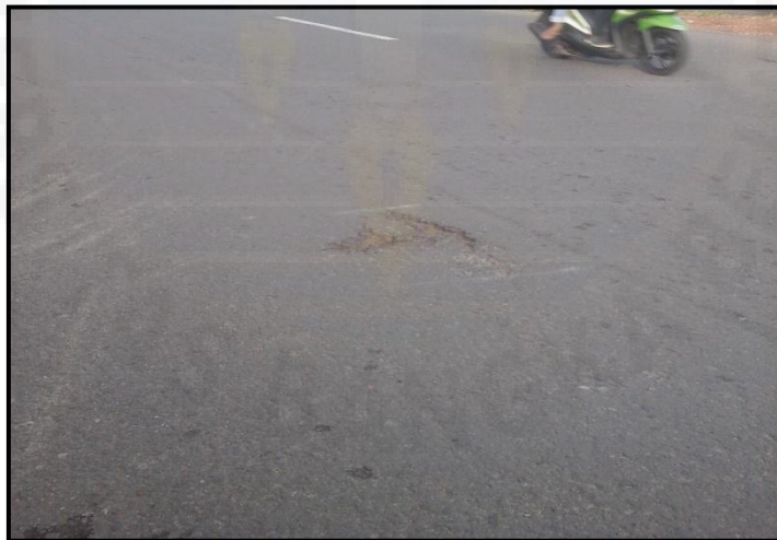
Gambar Kerusakan Keriting STA 0+042
