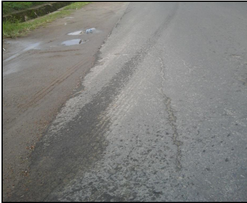
Gambar Kerusakan Retak Memanjang STA 0+980
