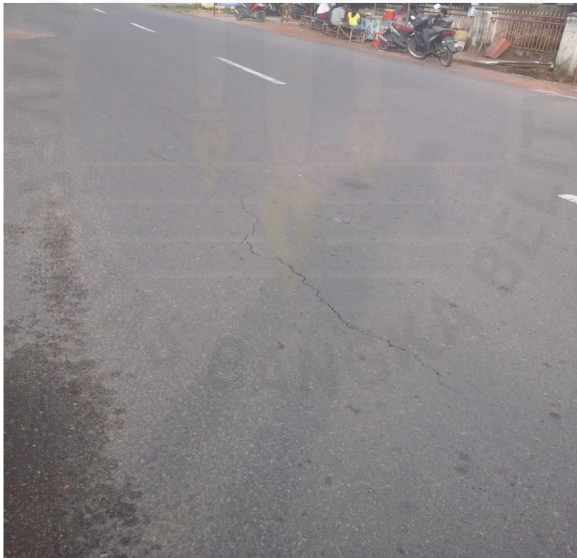
Gambar Kerusakan Retak Memanjang STA 0+150
