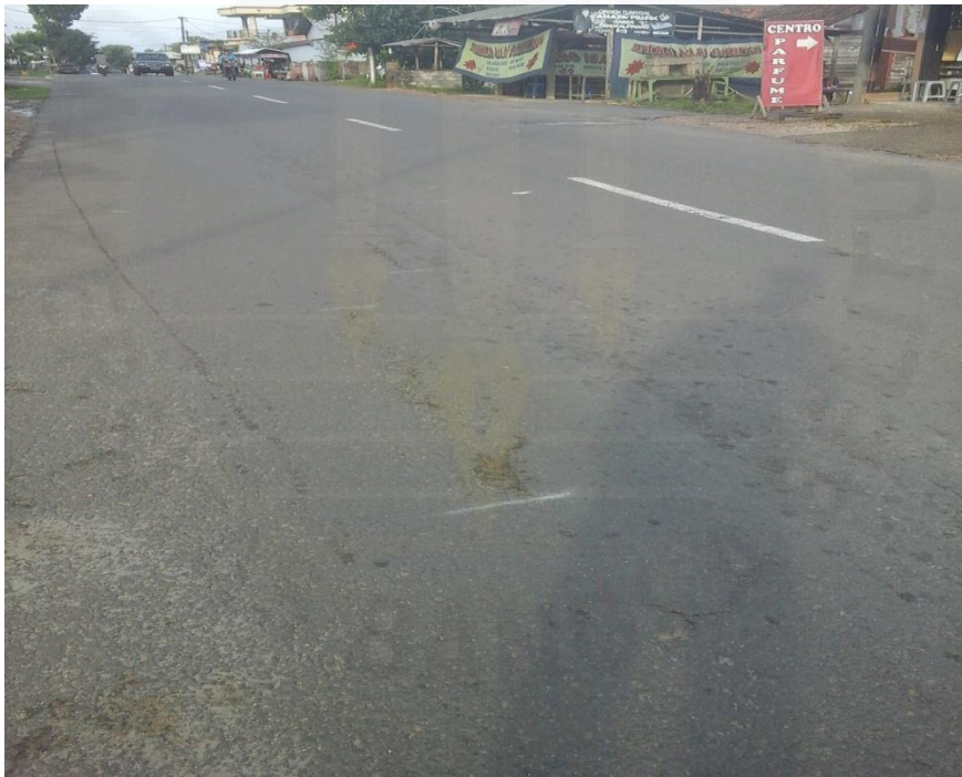
Gambar Kerusakan Retak Memanjang STA 0+092
