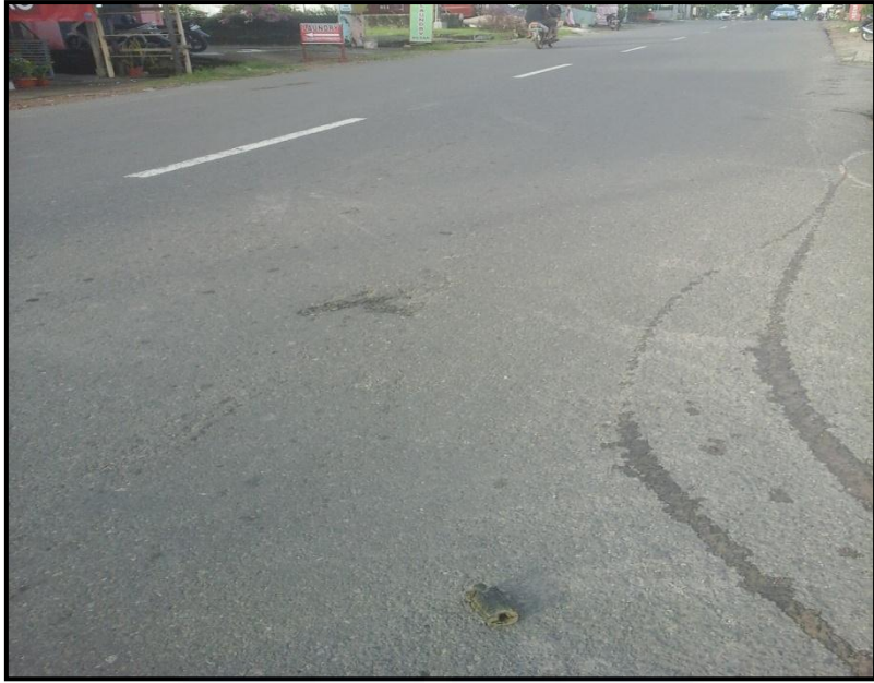
Gambar Kerusakan Keriting STA 0+044
