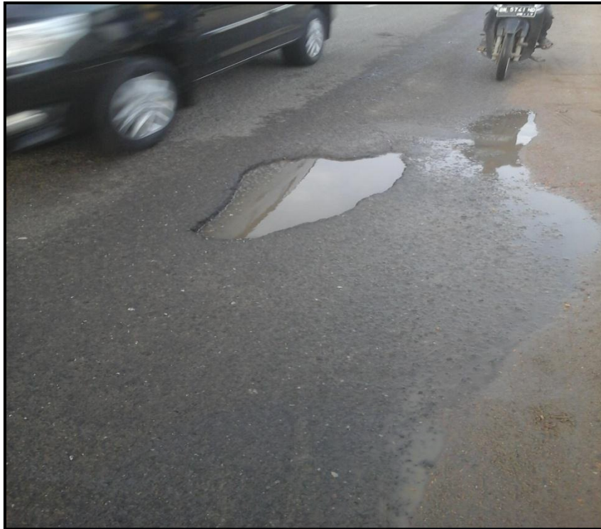
Gambar Kerusakan Lubang STA 0+570
