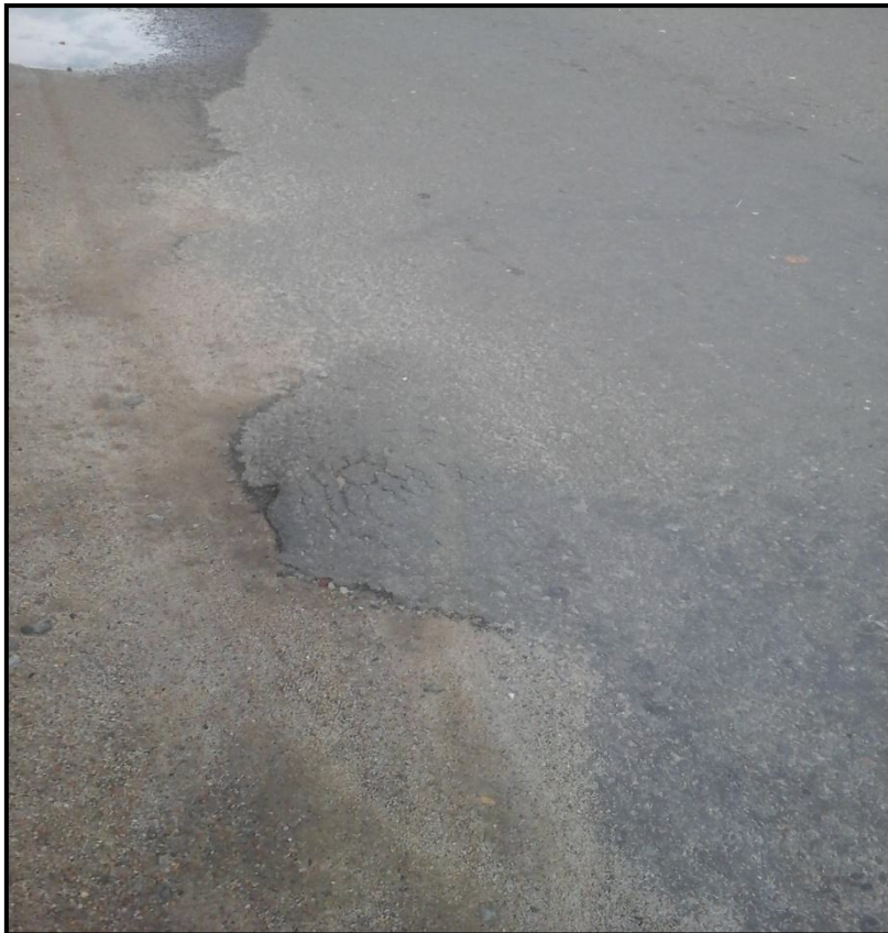
Gambar Kerusakan Kegemukan STA 0+860
