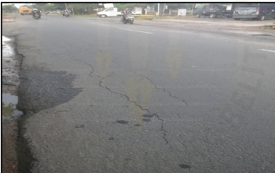
Gambar Kerusakan Retak Memanjang STA 0+600
