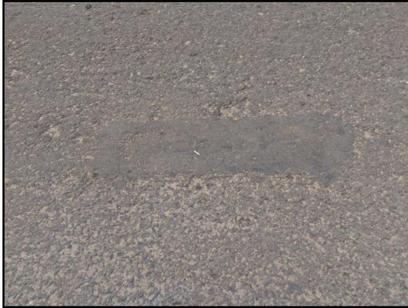
Gambar Kerusakan Tambalan STA 0+091
