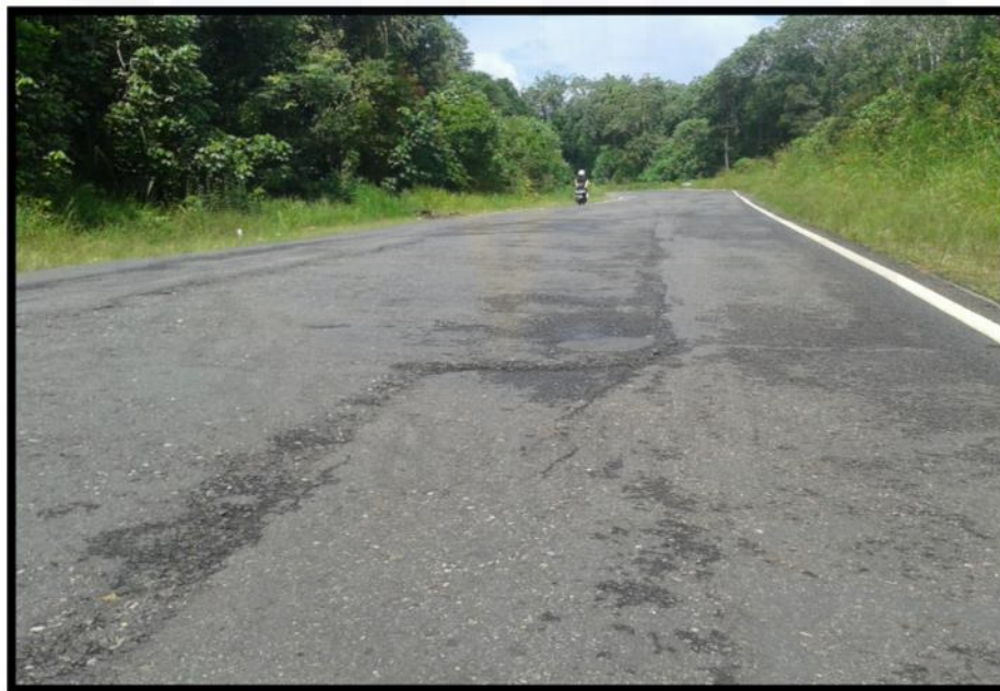
Foto permukaan jalan bergelombang
