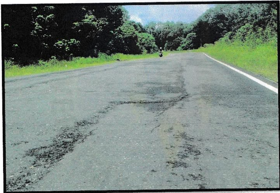
Foto permukaan jalan bergelombang
